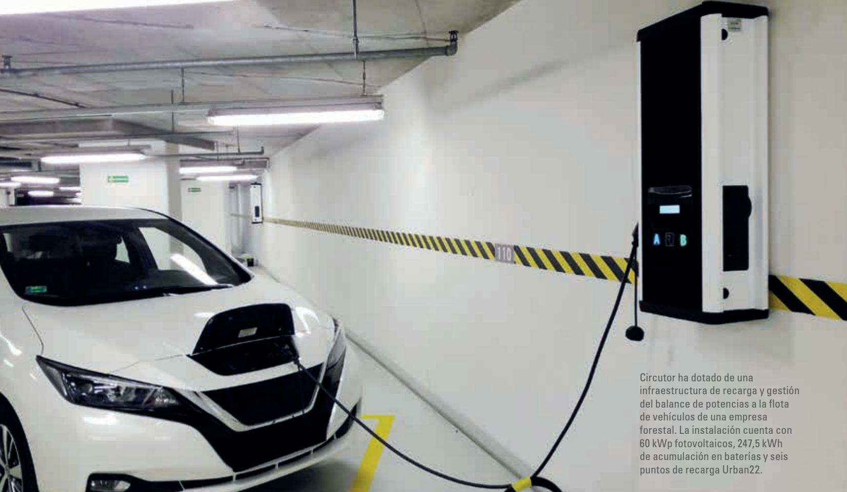
Circutor ha dotado de una infraestructura de recarga y gestión del balance de potencias a la flota de vehículos de una empresa forestal. La instalación cuenta con 60 kWp fotovoltaicos, 247,5 kWh de acumulación en baterías y seis puntos de recarga Urban22.
