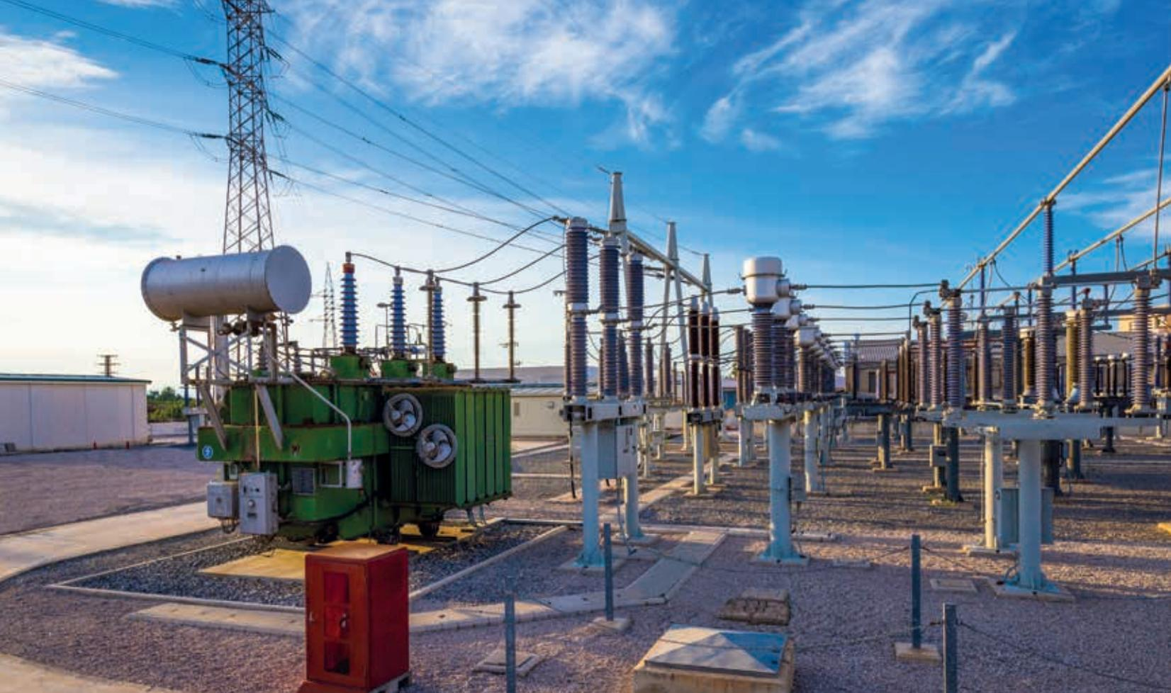
Es fundamental realizar verificaciones básicas para el óptimo mantenimiento de instalaciones en centros de transformación, como la medición de descargas parciales en los diferentes elementos, celdas, cables y transformadores.
