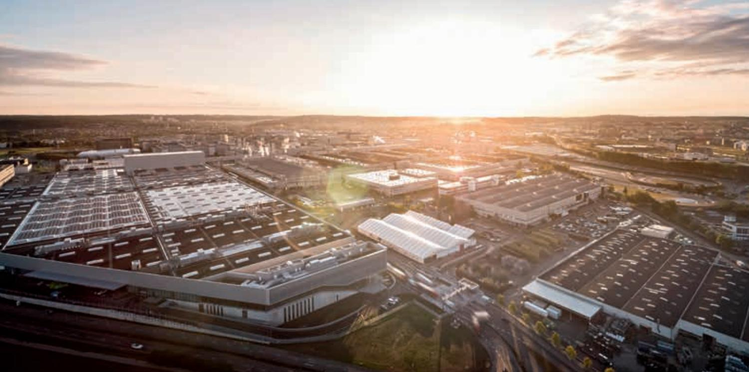
La cubierta de la Fábrica 56 de Mercedes Benz cuenta con una instalación de 12.000 módulos fotovoltaicos que generan 5.000 MWh de energía, que se utiliza directamente, se almacena o se inyecta en la red pública.
