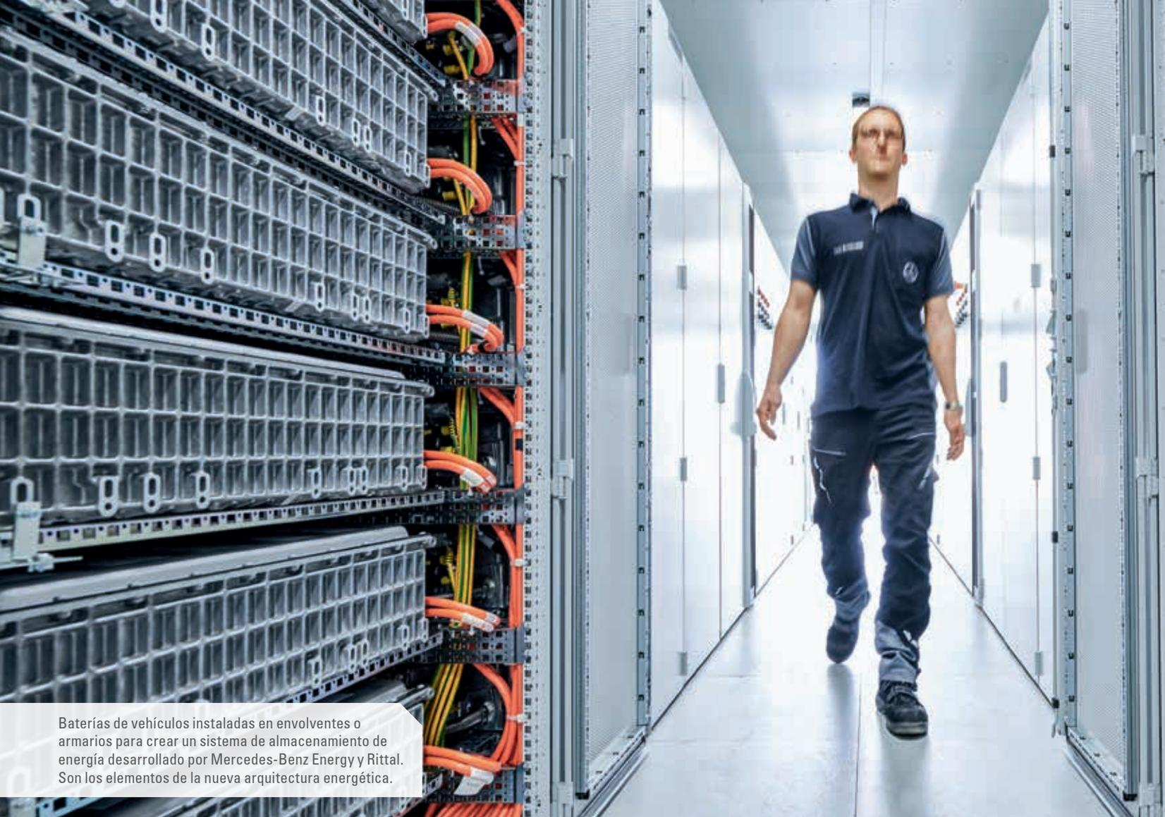
Baterías de vehículos instaladas en envolventes o armarios para crear un sistema de almacenamiento de energía desarrollado por Mercedes-Benz Energy y Rittal. Son los elementos de la nueva arquitectura energética.
